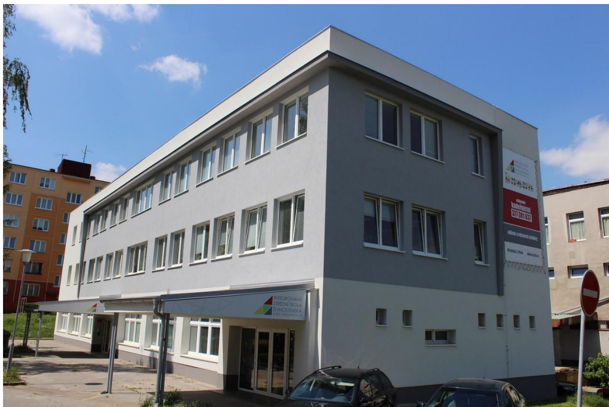
Budova školy Křimická ul. č. 3
